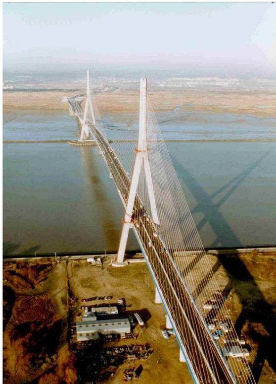
**Pont de Normandie, pont à haubans d'une longueur totale de 2141 m, avec une portée centrale de 856 m (1989-1995)**
