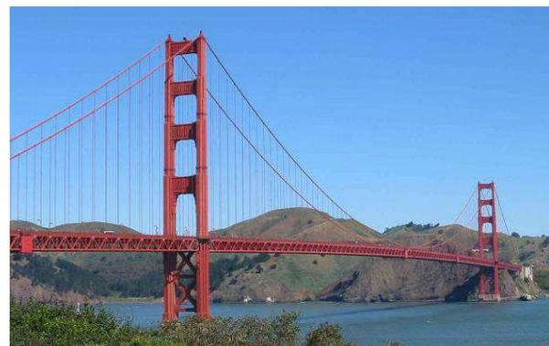
Le Golden Gate Bridge à San Francisco (États-Unis), commencé en 1917 et achevé en 1937. Il mesure 1970 m de long, la distance entre les deux tours principales étant de 1 280 m et leur hauteur est de 230 m au-dessus du niveau de l'eau.
