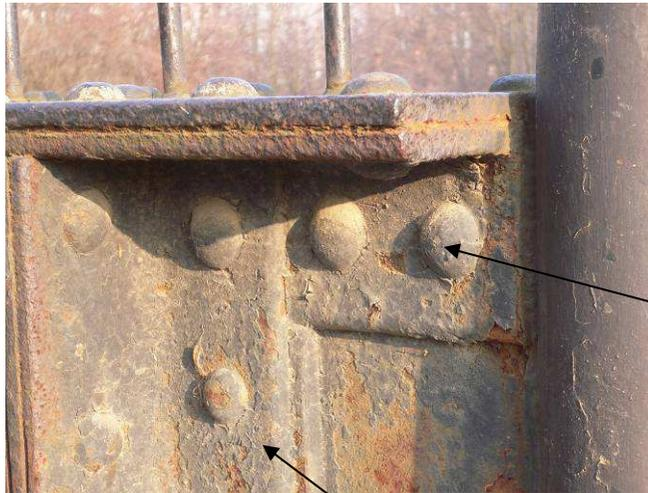
Ce mode d'assemblage s'avère long et cher. Une autre méthode est alors mise au point et en œuvre : l'assemblage par soudure.
