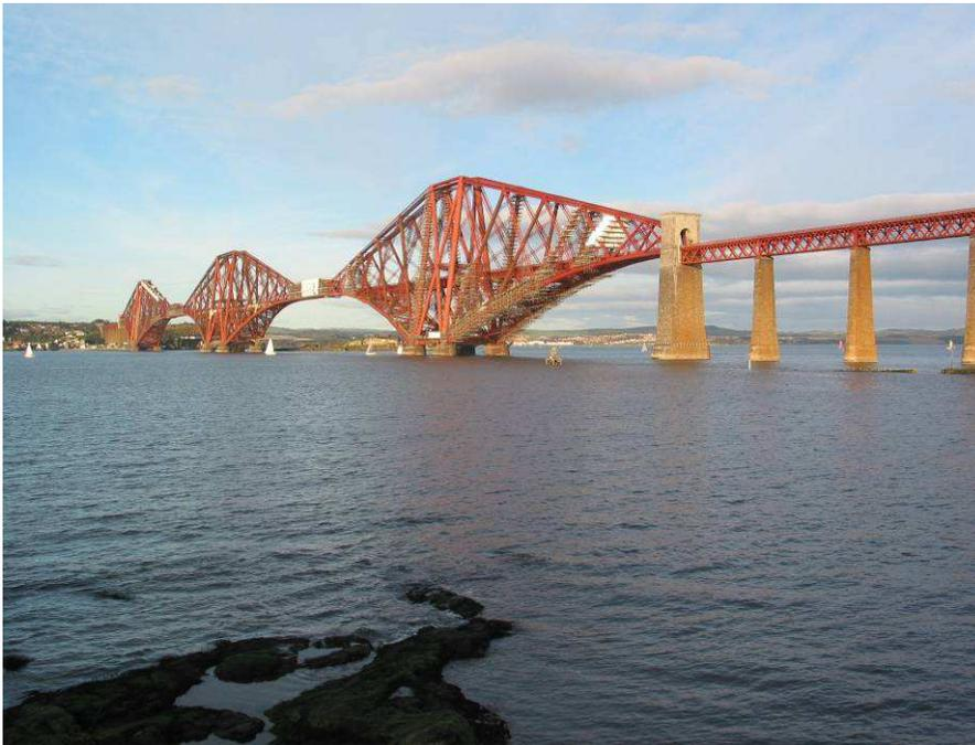
**Pont du Firth of Forth (Écosse), réalisé en 1890, avec deux travées de 521 mètres.**
